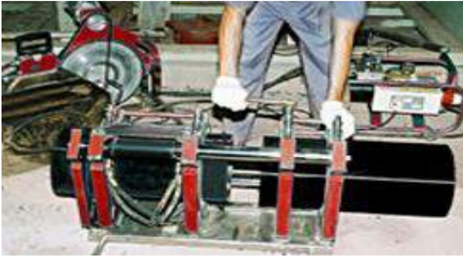
Hình 1.12. Vệ sinh đầu ống cần hàn, đặt các đoạn ống cần hàn vào giá đỡ
